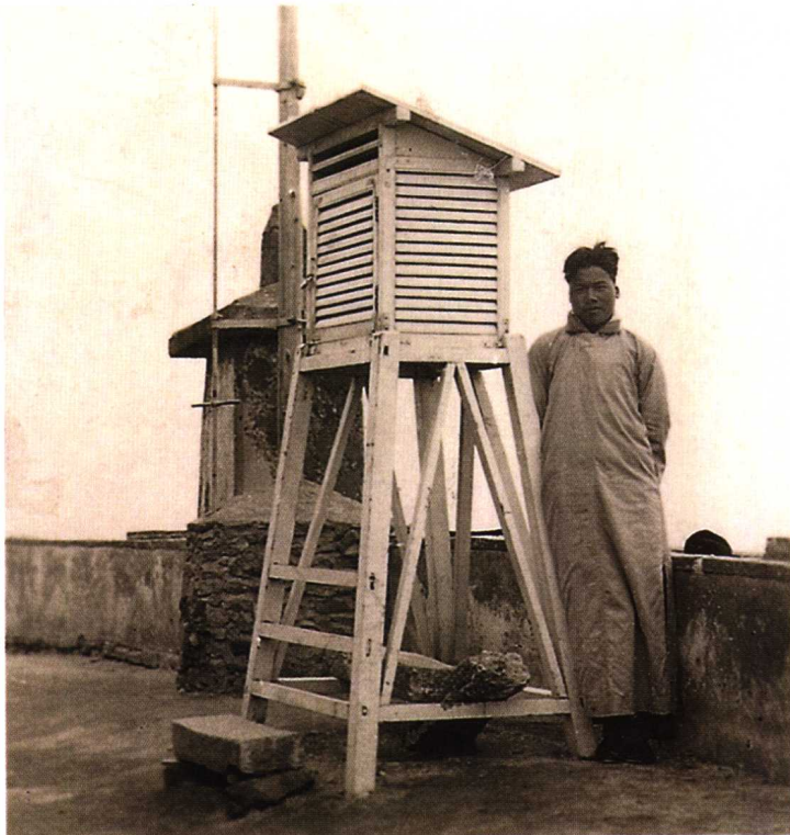
1931 年建立的泰山日观峰测候所
