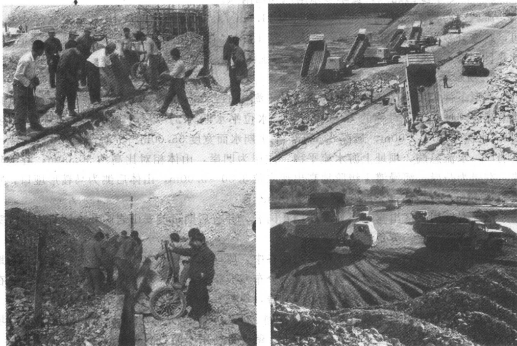
图 1-5 黑河象山水电站沥青混凝土心墙施工图片
