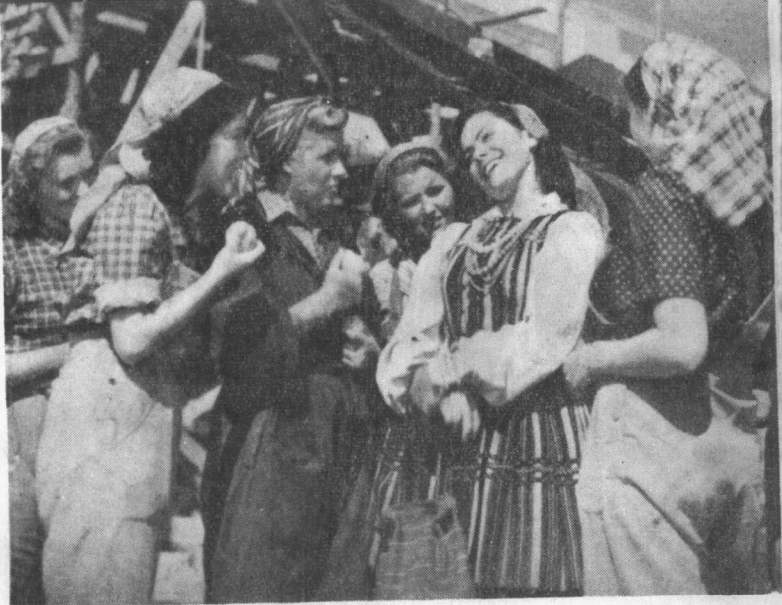
农村姑娘韓卡来到建設中的华沙城，她在工地上和砌磚女工們談話。
