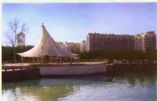
“江苏人居环境范例奖”获奖项目 ——常州市城市污水治理工程
