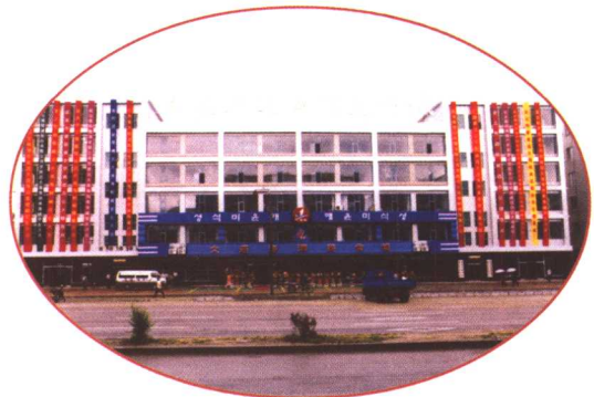
◆该公司承建的公司办公楼
