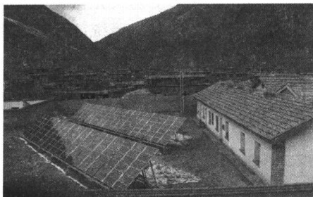
图 2-6 村落独立光伏电站
