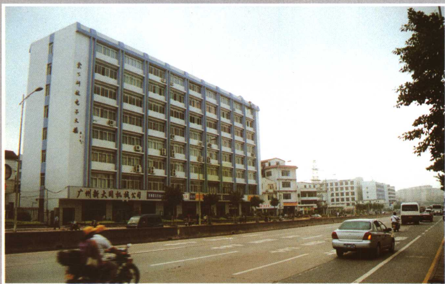
▶ 广州市东圃镇棠下村科技电子大楼（90年代）。
