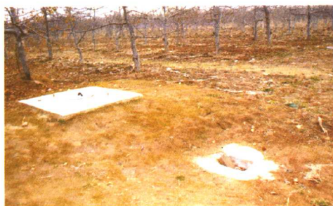
彩图5 集雨窖进水和取水口
