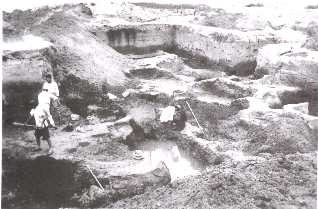
郑州人民公园内商代人民公园期遗址发掘现场
