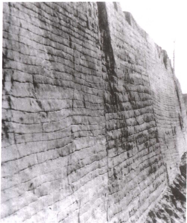
商城城墙夯土层
