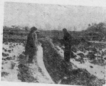
改良烂水田措施之一， 开排水沟
