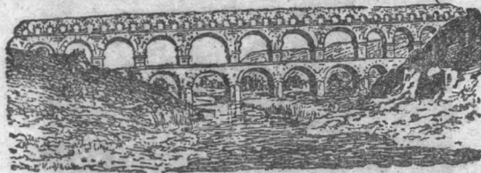
尼姆羅馬給水道的卡尔德渡槽(法國)
