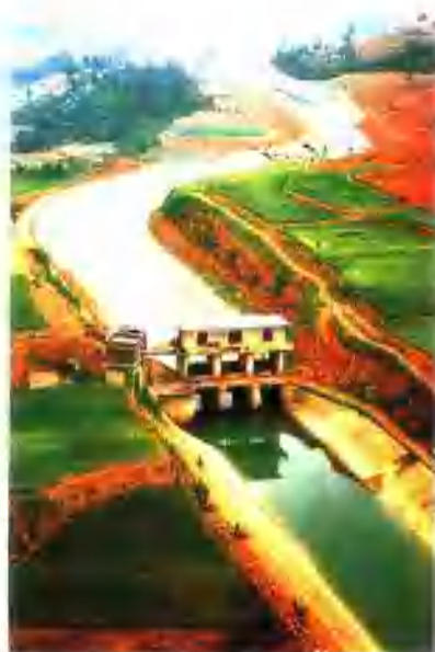
陆浑水库灌溉区干渠
