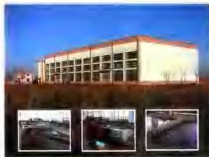
具有国内先进水平的水力学研究试验室
