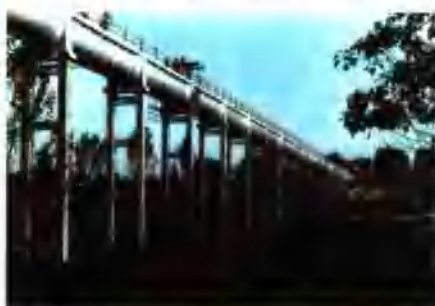
“四达公司”承担进行在老化、防渗处理的压山输水渡槽
