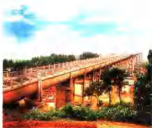
陆浑水库灌区西干渠伊河渡槽
