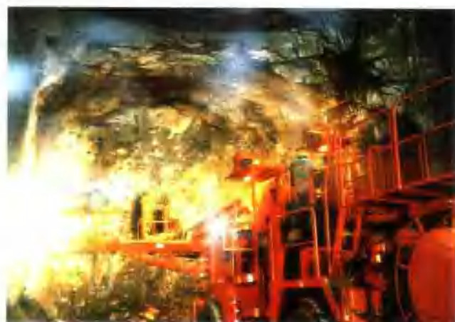
开挖中的20世纪洪洞
