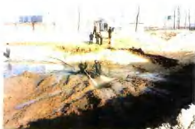
数九寒冬，职工在操作泥浆泵，开挖鱼塘
