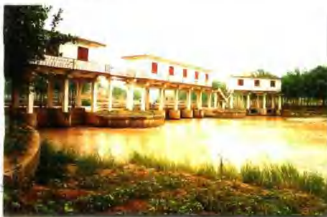
新三义黄灌区总干渠三分枢工程
