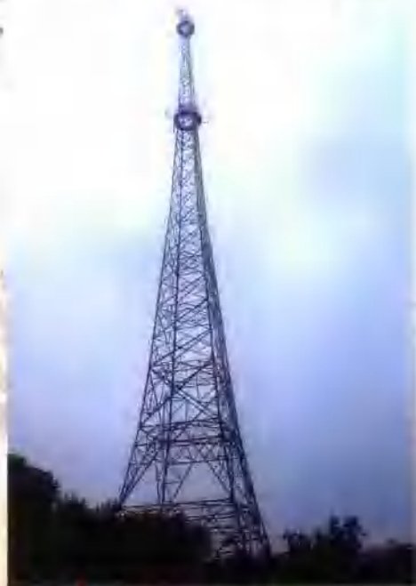
这是新建的高50米的水文 信息通讯铁塔
