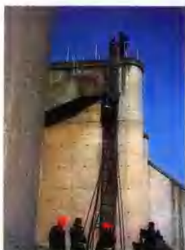
省水利电力质量检测中心承担的白沙水库世共间分无压隧洞
