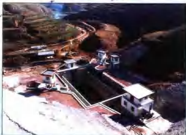
俯瞰小浪底水利枢纽南岸引水口出口分水枢纽工程
