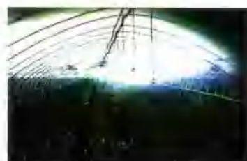
“节水公司”设计施工的大棚微灌工程
