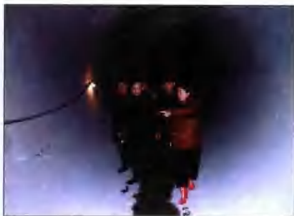
建管局常务副局长原喜琴(右)陪同原水利厅前总工程师马寿龙(左)检查南岸引水隧洞工程
