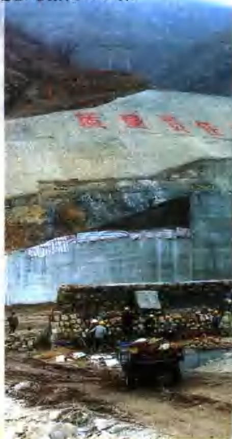
施工中的泄洪洞出口
