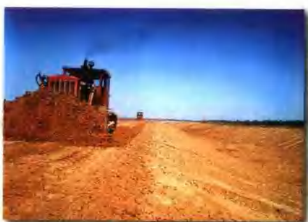
机械化施工的新三义寨南线供水工程
