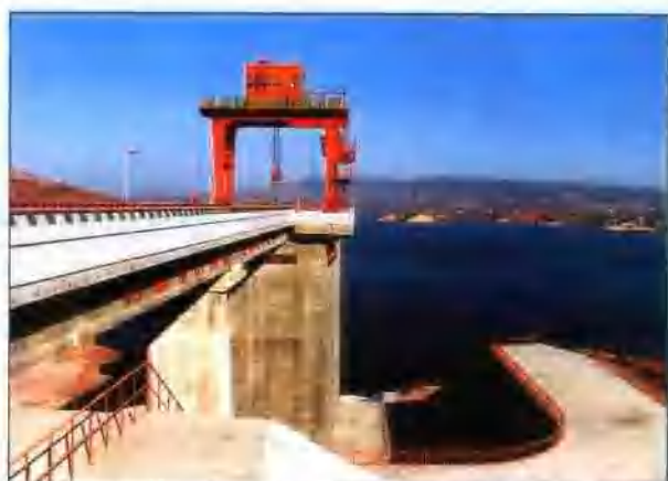
过水隧洞50K门式起重机及预应力T型梁 汽-15交通桥
