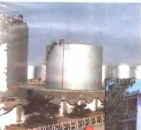
南阳石油站油库
