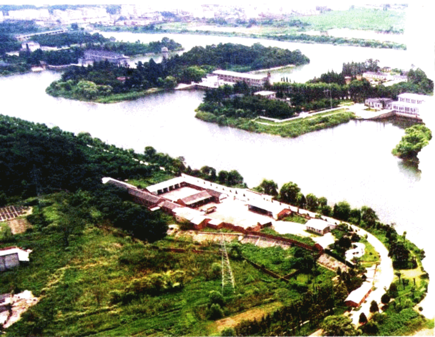
举世闻名的江都水利枢纽工程
