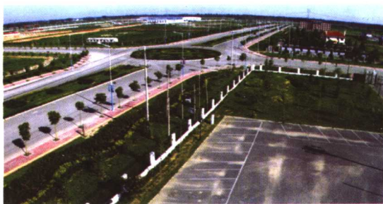
北京市大兴区采育镇工业区主路
