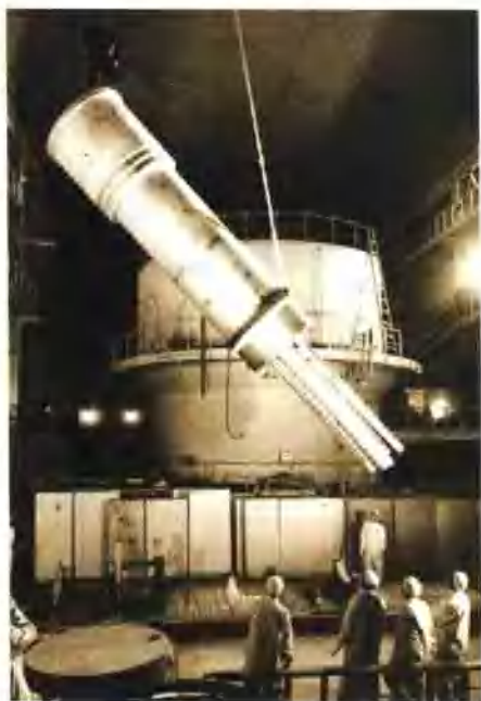
1979 年 101 重水研究堆大修改建中吊装新内壳
