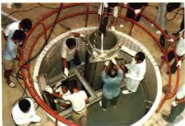
深圳微堆在建设中
