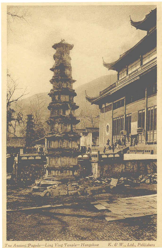
1-1-5 灵隐寺大雄宝殿前宋代石塔
