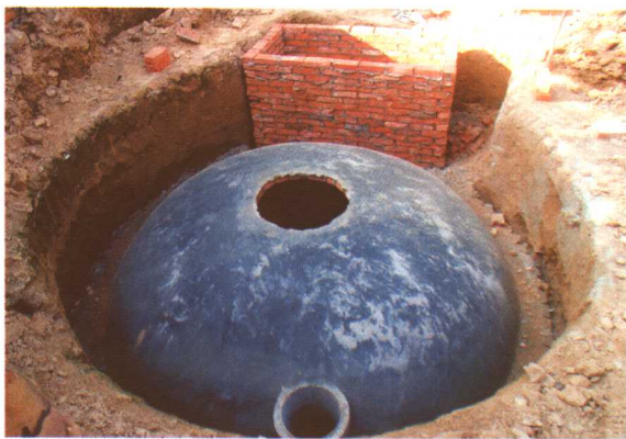
沼气施工现场
