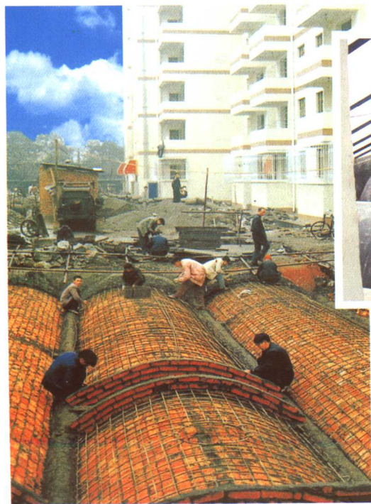
城镇污水净化沼气池
