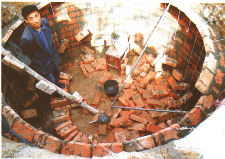
沼气施工现场
