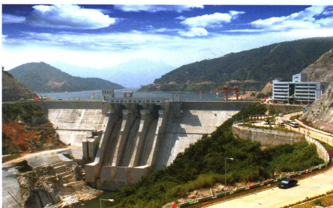
福建棉花滩碾压混凝土坝
