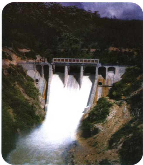
我国第一座全碾压混凝土坝——福建大田坑口坝
