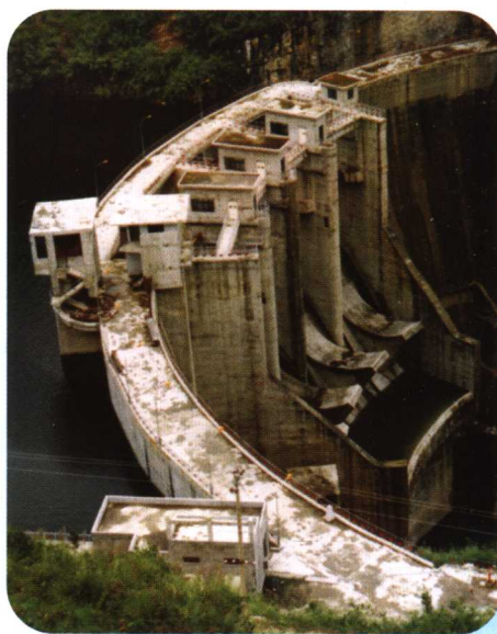
我国第一座全碾压混凝土拱坝——贵州普定坝
