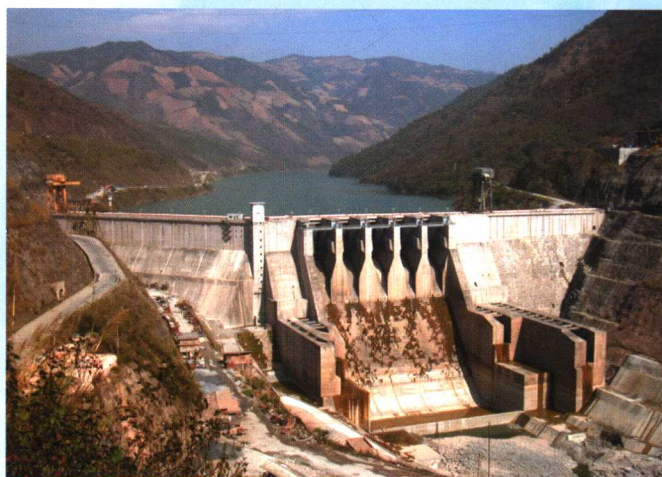
云南大朝山碾压混凝土坝
