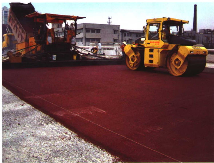
彩图 5 彩色路面施工
