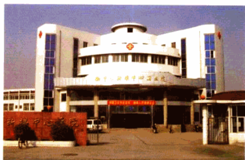
新坝中心卫生院
