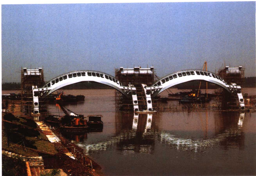
河口公园的橡胶坝
