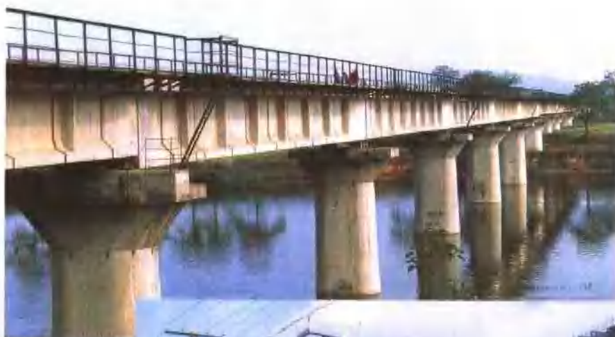
1990 年兴建的平顶山—禹州市铁路北汝河大桥。
