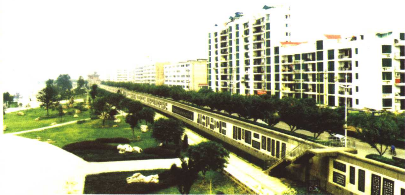
常德城市防洪墙——常德诗墙
