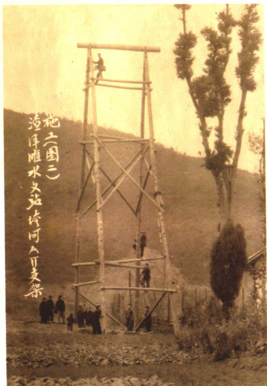
渣洋滩水文站跨河支架施工现场 (1958年)
