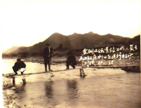
金刚山流量站工作人员在人工河床断面上进行枯水测流 (1959年)
