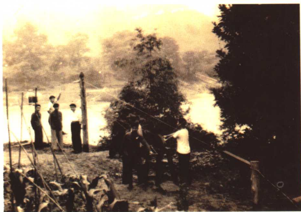
全省水文第二座高架浮标投掷器架设现场 (1953年·东江站)
