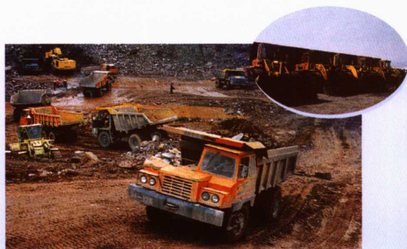
1989年成立的拥有挖掘机、装载机等多种机械的柿槟工程公司在国家重点工程小浪底施工现场
