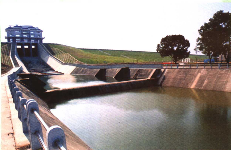
横山水库溢洪闸
