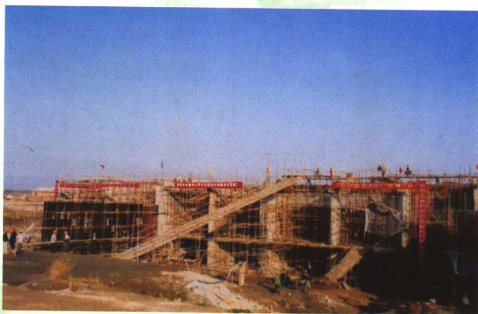
白屈港闸站土建工程施工
