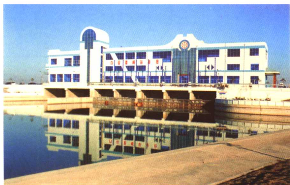
武澄锡引排工程白屈港抽水站
