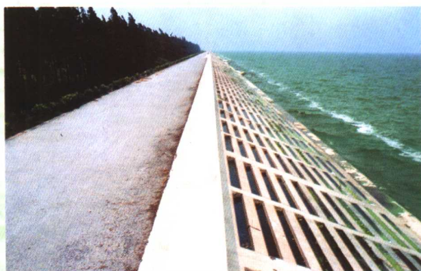
太湖大堤混凝土格网护岸
