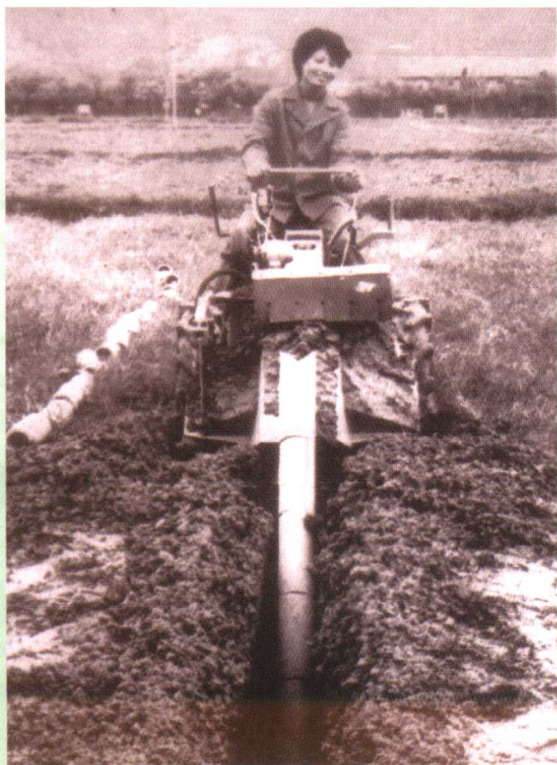
农田地下暗降管道机械施工
