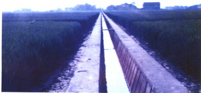
田间混凝土板衬砌排水沟
