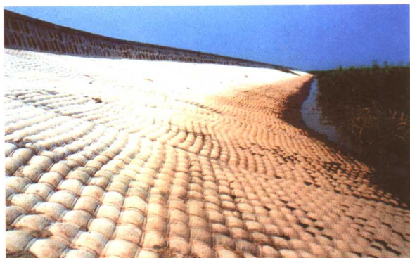
长江大堤土工模袋混凝土护岸
