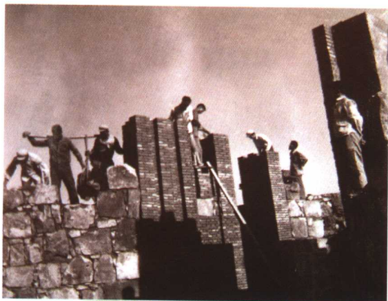
20世纪60年代圩口闸施工
