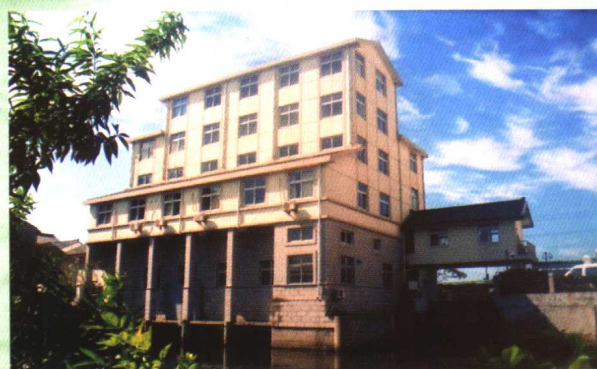
北塘联圩三里桥排涝站
