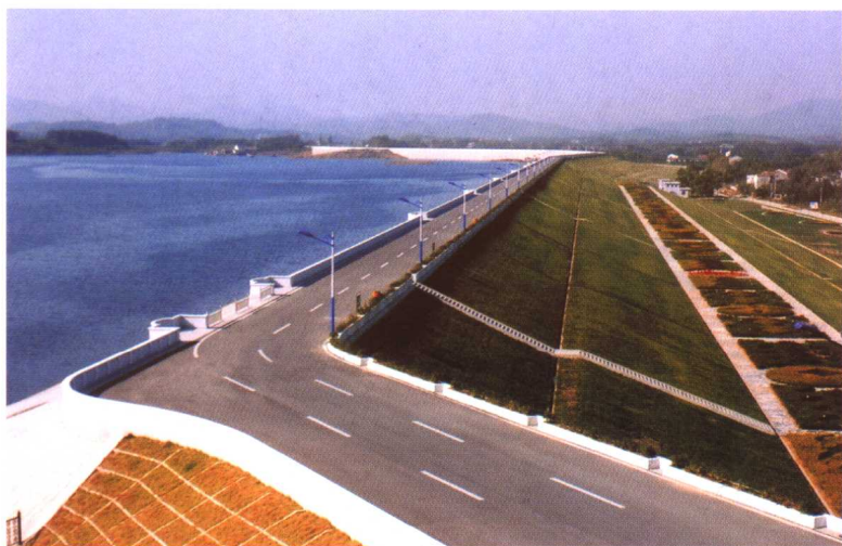
横山水库大坝
