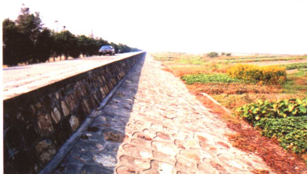
长江大堤浆砌块石护岸及挡浪墙
