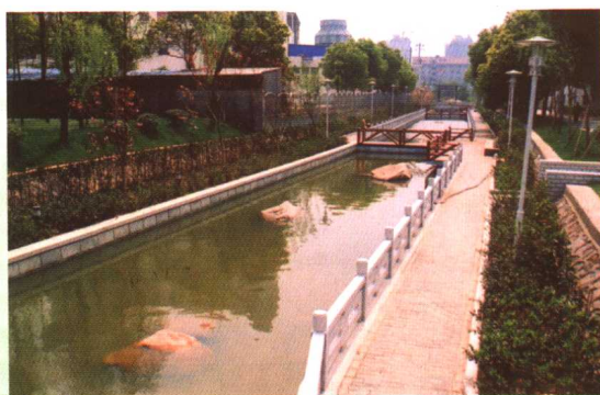
无锡市区沁园新村河浜治理
