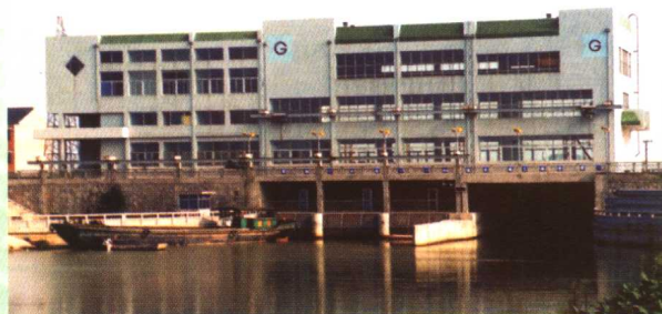
武澄锡引排工程新夏港抽水站
