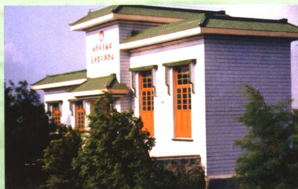
江阴月城马圩第二排涝站
