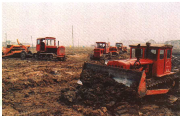
土方工程机械化施工
