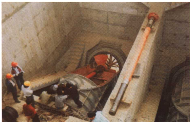
新夏港抽水站机泵安装
