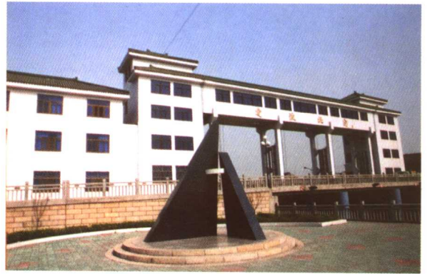
江阴长江大堤定波北闸
