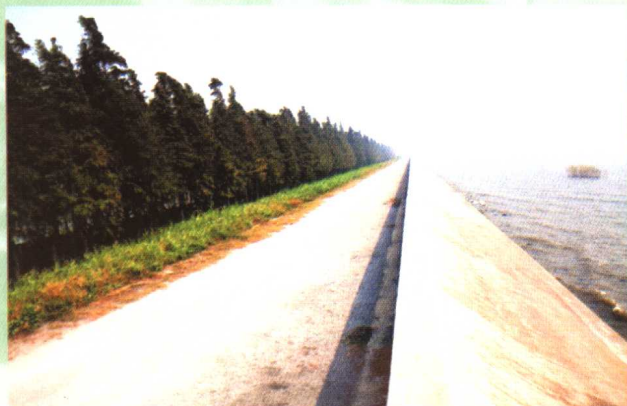
太湖大堤混凝土护岸及挡浪墙
