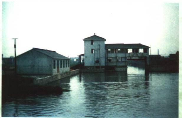
锡山玉东圩北圩口闸
