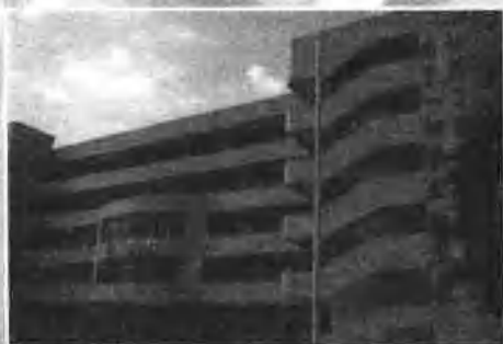
东城中学科学楼（肇庆市一级学校）
