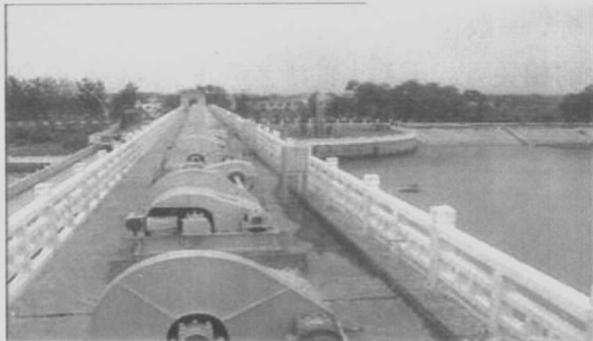
图 1-4 南水北调工程
