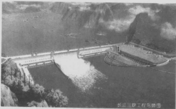
图 1-3 长江三峡工程
