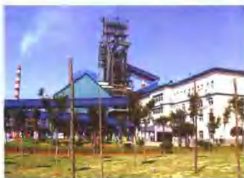
2005年9月，中钢设备公司与土耳其ISDEMIR 钢厂签订3000立方米高炉工程总包合同
