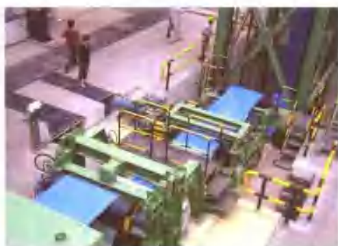
印度JINDAL钢厂年产10万吨彩涂线工程
