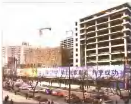
正在建设中的西西4号工地
