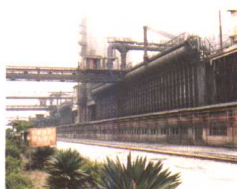
▲ 贵阳管道煤气项目
