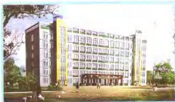
▲ 逸夫综合教学楼
