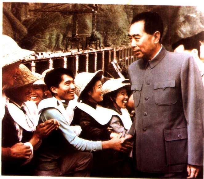
1960年周恩来总理视察三门峡 大坝工地，同工人亲切交谈
