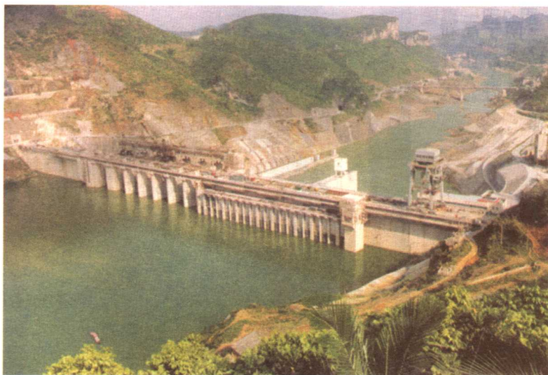
↑ 加强水利建设——岩滩水电站
