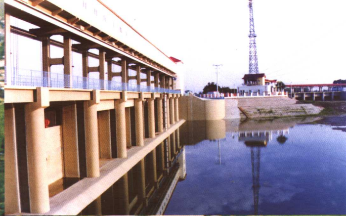
2000年8月20日摄屈家店防洪闸
