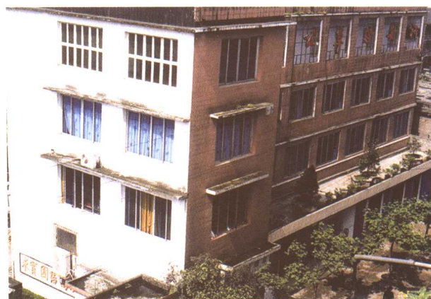
江安县烟草专卖局、江安县烟草公司办公楼。
