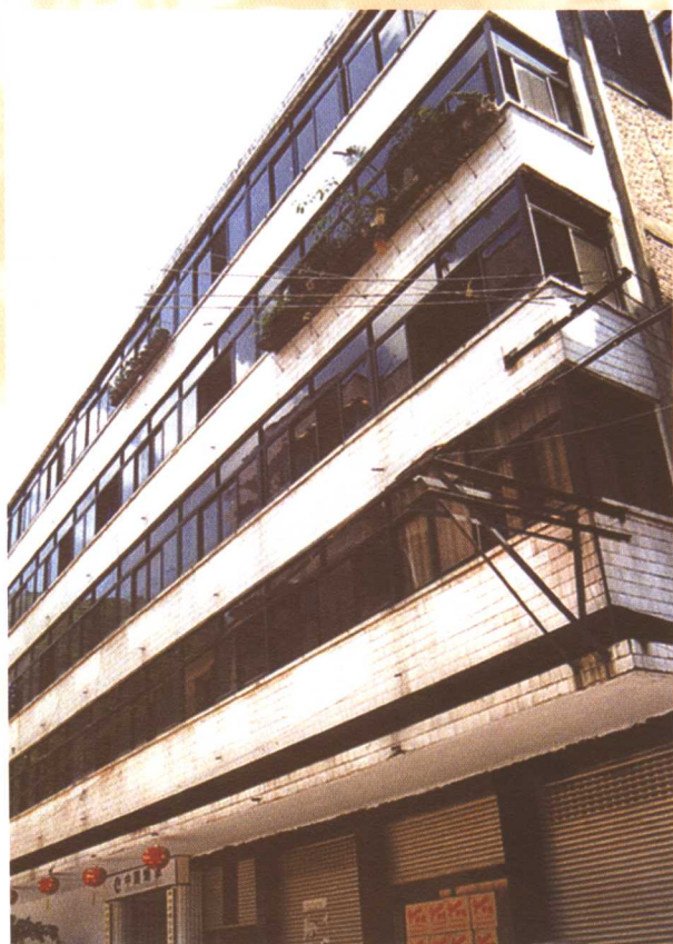
屏山县烟草专卖局、屏山县烟草公司办公楼。
