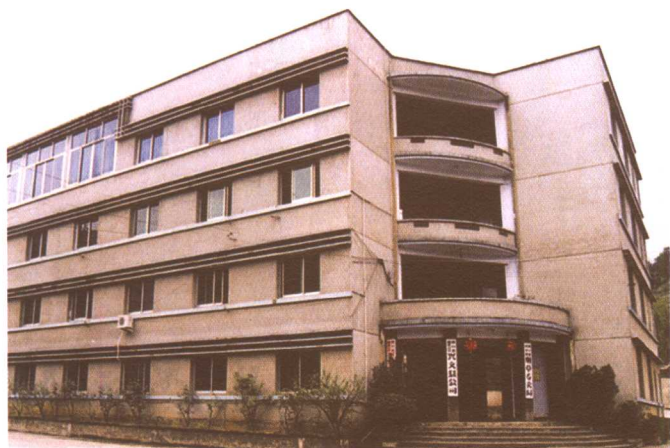
兴文县烟草专卖局、兴文县烟草公司办公楼。
