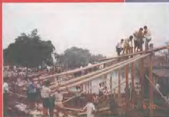
在抗洪中，筑堤和修筑临时大堤
