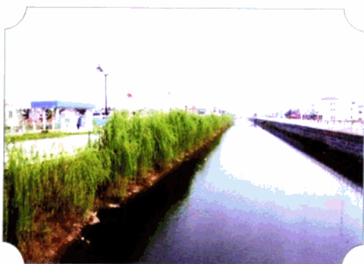
▲ 新桥镇总灌渠
