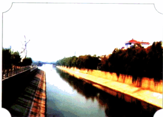
▲ 丹阳南门分洪道
