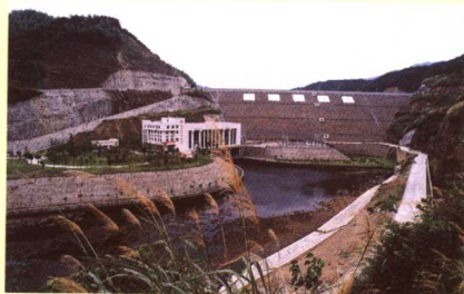
宣城港口湾水库工程，总库容9.41亿立方米。 开竣工时间：1998.10-2001.12
