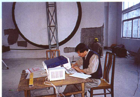
省监督检测二站工作人员正在做黄山市太平索道混凝土的超声波检测
