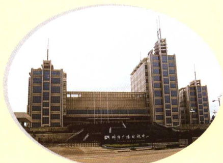
蚌埠广播电视中心工程，总建筑面积34500m 2 。 开竣工时间：1998. 5-2002. 12
