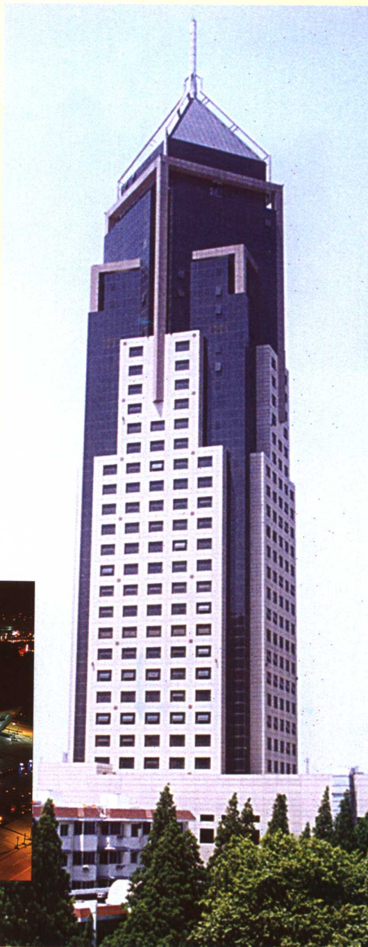
省邮电通信调度中心工程，地下三层，地上三十九层，地上高度178.38米。该工程层数、高度为省内同类型工程之最。开工时间：1996.7-1999.9
