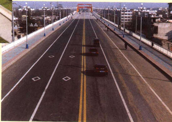
六安市皋城路大桥工程，总投资2100万元。 开竣工时间：2000.6-2002.1
