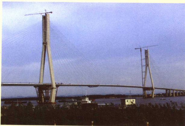
建设中的安庆长江大桥，计划投资：13.174亿元。 开工时间：2001.11
