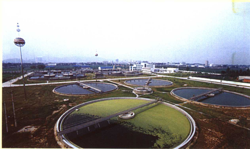
淮北市污水处理厂工程，日处理污水80000吨，总造价1.02亿元。 开工时间：2000.4-2001.8
