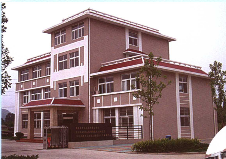
马鞍山市当涂县质监站质监综合楼
