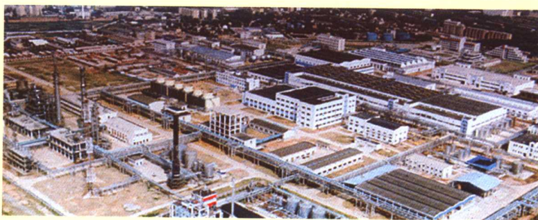
安庆石化总厂年产5万吨丙烯腈-腈纶工程，工程总投资40.59亿元。开工时间：1992.11-1996.12
