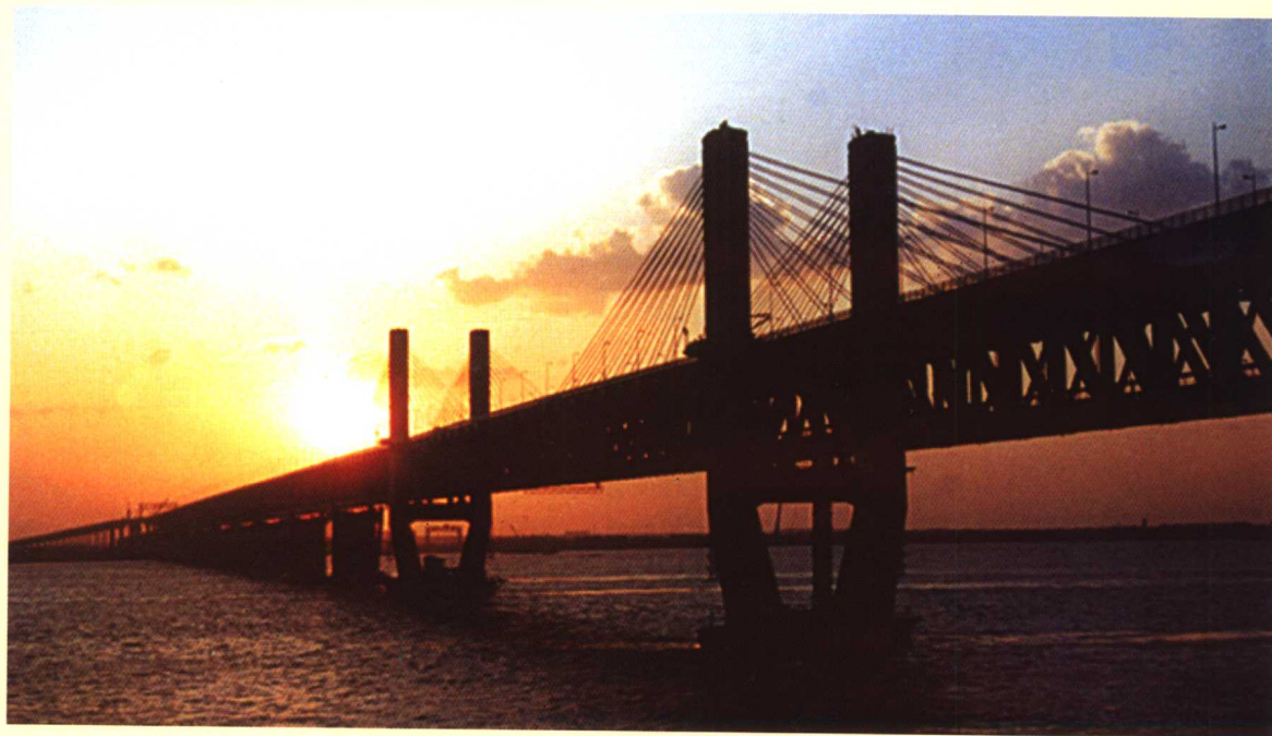
芜湖长江大桥总投资45.46亿元，为我省第一座公铁两用长江大桥，它是我省的标志性工程。 开竣工时间：1997.3-2000.9
