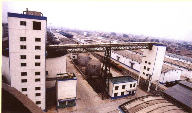
宿州粮库工程，总建筑面积11900m 2 ，总投资830万元。 开竣工时间：1998. 11-1999. 6
