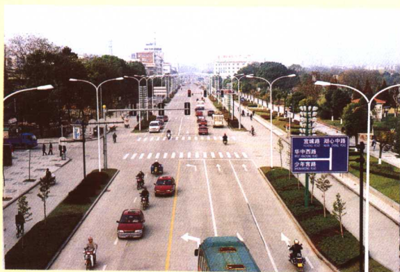
安庆市菱湖南路工程，总投资3500万元，道路长2438m，宽40m。开竣工时间：2002.6-2002.12
