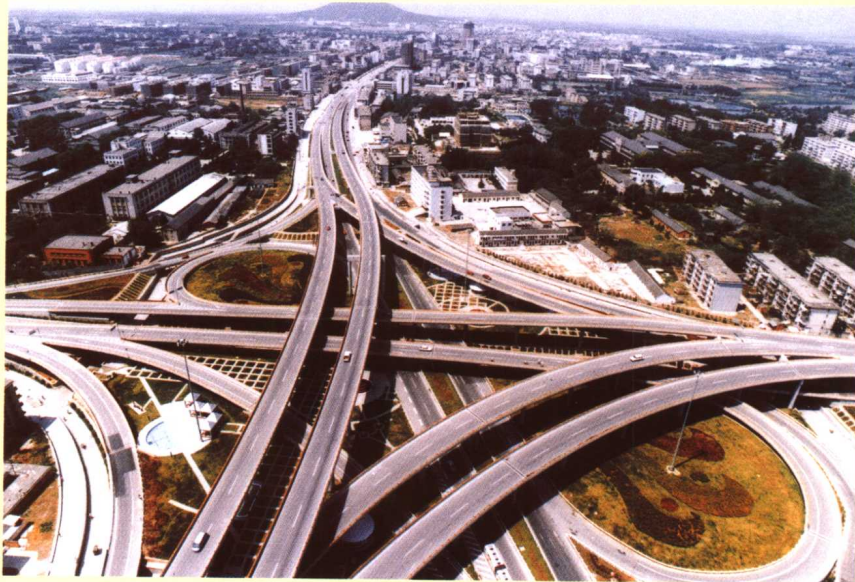
合肥五里墩立交桥工程，总投资2.6亿元。 开竣工时间：1995.6-1996.6
