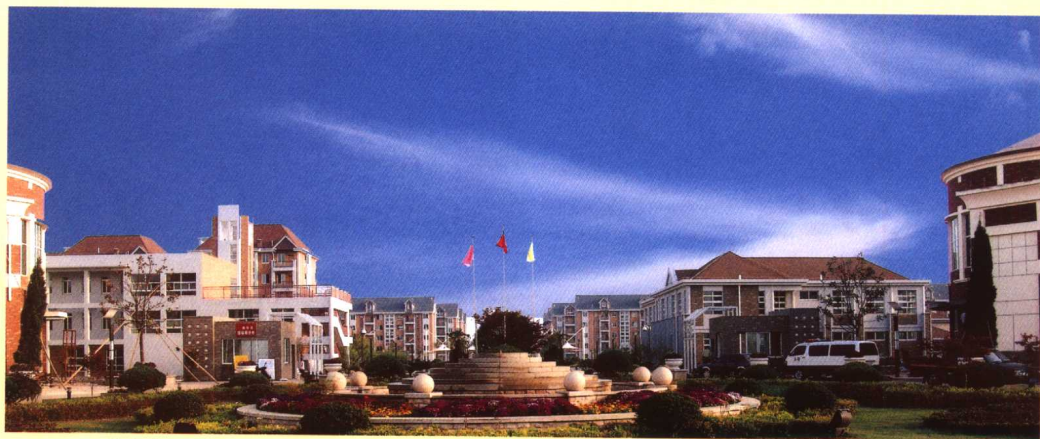
淮北市温哥华城锦华苑小区一期工程，总建筑面积18万平方米。该小区建在淮北煤矿塌陷区， 基础采用淮北电厂工业废料填充。开竣工时间：2002. 11-2004. 4
