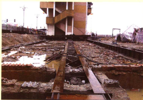
安徽省首例大楼平移工程，所平移大楼为七层， 总重量7000吨，纵向移动38米，横向移动20米，并 升高0.9米。平移大楼所在地：安庆市
