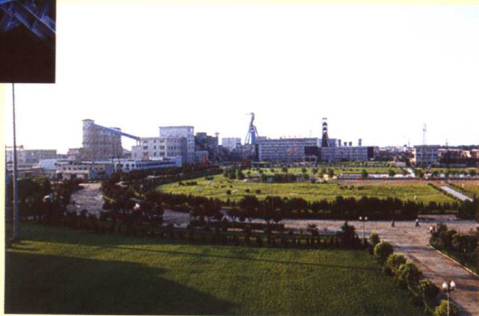
淮南张集矿井工程，实际完成投资17.4亿元。开工时间：1996.7-2001.11
