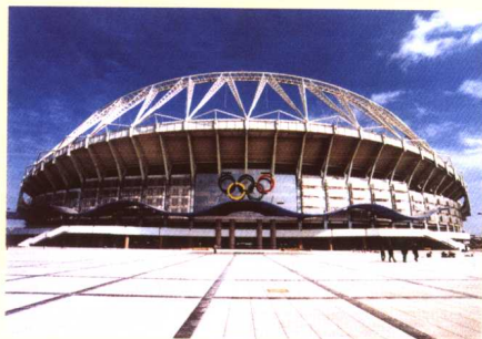
芜湖奥林匹克公园体育场工程，是一座多功能、现代化的体育场，总建筑面积45000m 2 。 开工时间：2001.12-2002.10
