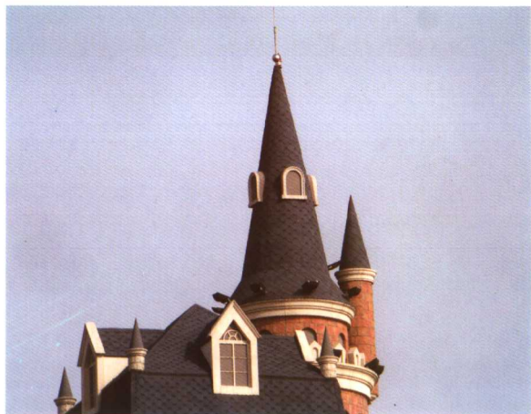
▼ 建筑屋顶实拍效果
