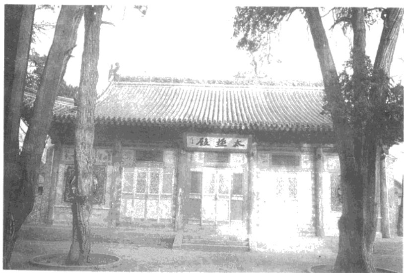
图 3 天水伏羲庙太极殿
