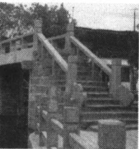
朱家角井亭港上的通泉桥。
