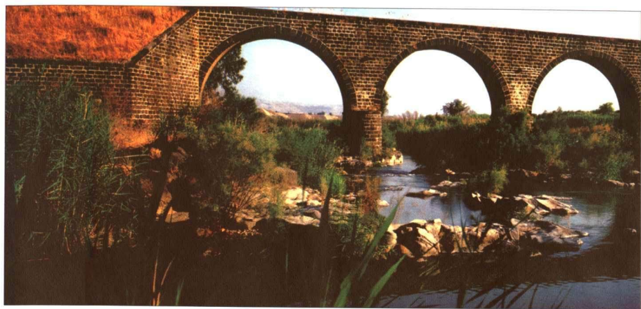
约旦河古石桥
