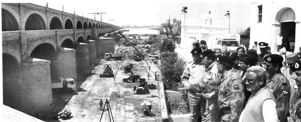
在信德省视察印度河上苏库尔堰坝的修复工程
