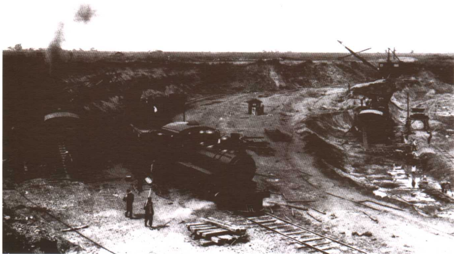
为井工煤矿提供充填砂石的采砂厂。摄于1917年6月。
