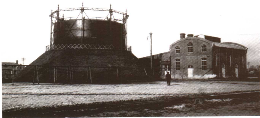
抚顺炭矿的瓦斯罐及瓦斯工场。摄于1909年11月26日。
