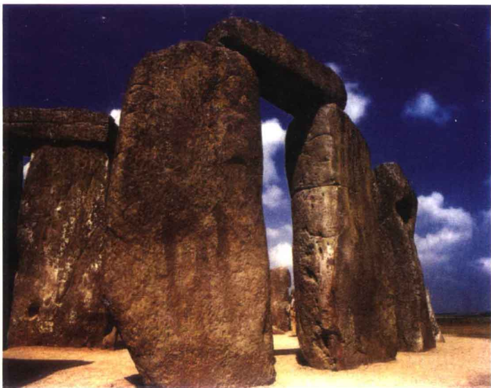
▲ 石柱上部架着楣石，构成柱顶盘
