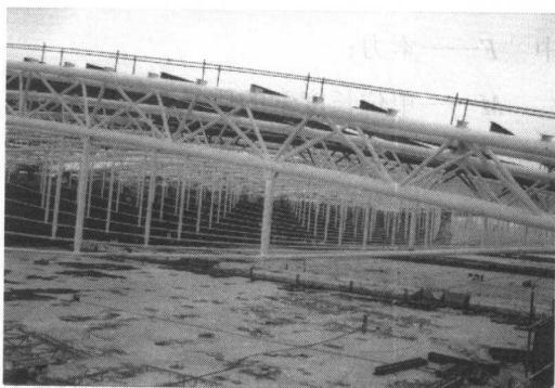
图3 施工中的钢屋架
