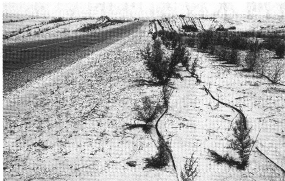
新疆维吾尔自治区利用公路两边的滴灌技术固定滴头
