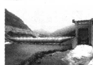
我国橡胶坝建设取得新突破 高6米、长102米的钢丝骨架彩色橡胶坝近日在广西都江百色东桥河上建成，标志着我国橡胶坝建设取得新突破。
