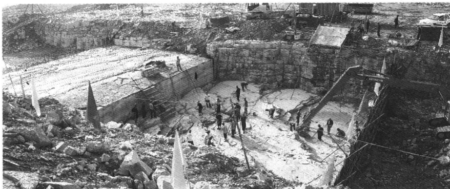
基础施工现场
