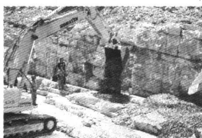
浇筑第一仓混凝土
