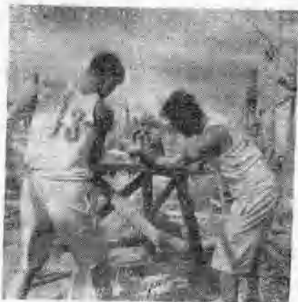
图7 进行水管套筒加工，以便安装
