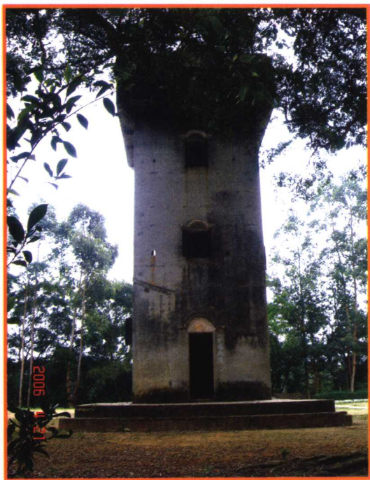
马岗联合镇南楼
