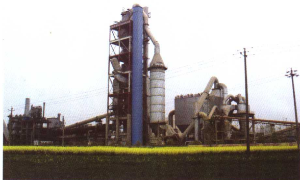
汉中水泥厂（汉中建材股份有限公司）
